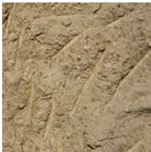
Eksempel på kløvede betonoverflader i forbindelse med MAGMA Kunst- og Kongrescenter på Tenerife fra 2005 af Fernando Martin Menis. Foto: TJA.
