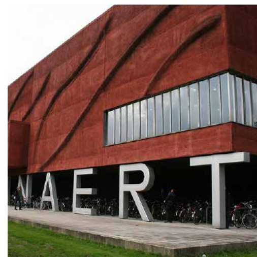
Sprøjtstøbte betonoverflader på Minnaert Building i Utrecht, Holland, fra 1997 af Neutellings Riedijk. Foto: TJA.
