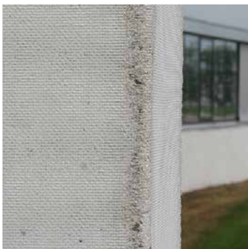
Tekstiler blev anvendt som indlæg i forskallingen i forbindelse med HEART i Herning fra 2009, arkitekt Steven Holl. Tekstilerne skaber en særlig »stoflig« tekstur – inklusive foldninger i stoffet. Foto: TJA.
