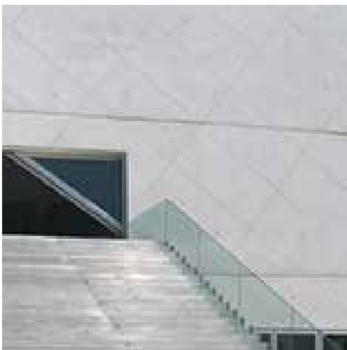
Et eksempel på at formsamlinger kan udgøre et mønster på facaden og fremhæve arkitekturen. Casa Musica i Porto, Portugal, fra 2005 af OMA. Foto: Mette Seiding.
