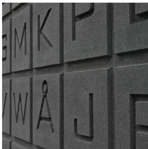
Betonooverflader med relieffer. Aller Tryk i Taastrup fra 2002 af Gottlieb og Paludan Arkitekter. Foto: Tommy Bæk Hansen. Ved Aller Tryk er bogstaverne placeret tilfældigt, men det krævede en omfattende »kvalitets-sikring« at undgå, at der opstod ord eller udsagn i overfladen.
