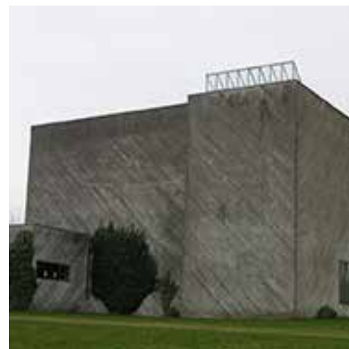
Gug Kirke i Aalborg fra 1972 af Inger og Johannes Exner. Selvom kirken nu har modtaget 46 års patinerings, synes denne at være forholdsvis ensartet, primært på grund af betonoverfladens grove karakter og skråstilte bræddestruktur. Foto: HBN.
