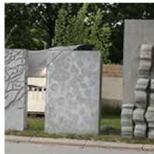
Teknologisk Institut (TI) har udført en række demonstrationsforsøg med relieffer skabt via digital produktion. Mulighederne er som det ses store, men effekterne skal anvendes med betydelig arkitektonisk forsigtighed. Foto: Foto: TJA.
