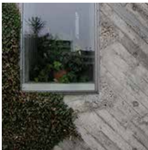
Støbt mod ru forskalling. Gug Kirke ved Aalborg fra 1972 af Inger og Johannes Exner. Foto: Hans Bruun Nissen (HBN).
