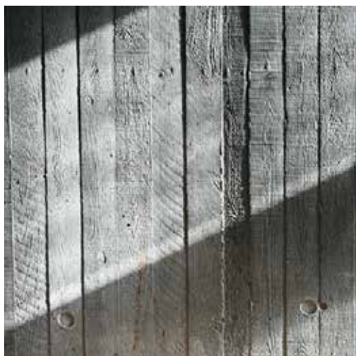
Støbt mod ru forskalling. Sælarium – udvidelse af Nord-sømuseet i Hirtshals fra 2001, Friis & Moltke Arkitekter. Foto: TJA.
