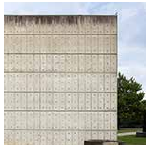
Facade på Roskilde Amtsgård fra 1979 af Knud Munk, hvor konushullerne er placeret i et mønster, der understreger bygningens arkitektur. Foto: Torben Eskerod.
