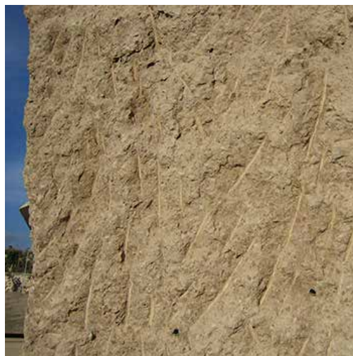
Eksempel på kløvede betonoverflader i forbindelse med MAGMA Kunst- og Kongrescenter på Tenerife fra 2005 af Fernando Martin Menis. Foto: TJA.
