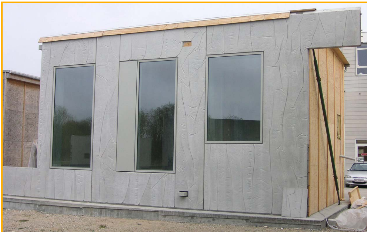
Det er en god idé at udføre 1:1 prøvestøbninger med relevante udsnit af facaden.
