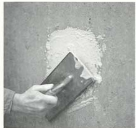
Påføring af pasta på lodret overflade.
